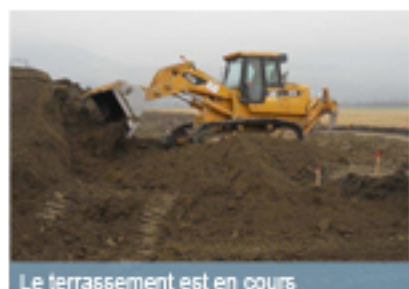
Le terrassement est en cours
