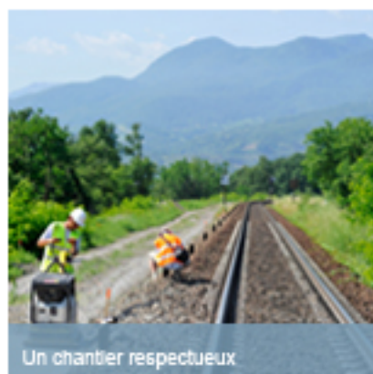
Un chantier respectueux
